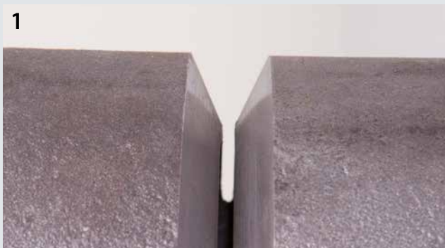
Preparación de costura de una soldadura de raíz en el tubo, ángulo de apertura de 60° y separación de 3 mm
