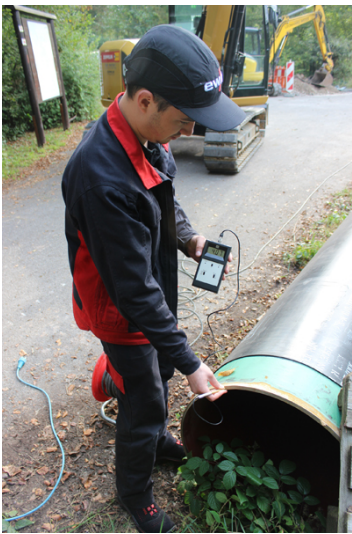
Prüfen der Feldstärke an dem neuen Rohrabschnitt.
