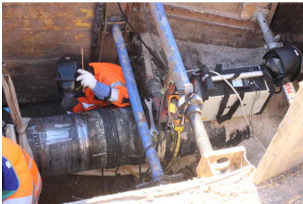
Erfolgreiche WIG-Schweißung an einem Flansch zwischen einem Rohrabschnitt und einem Kugelventil.
