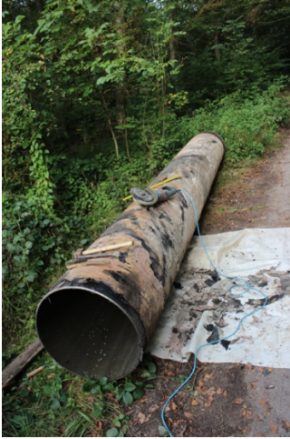
Außenseite des betroffenen Rohrabschnittes.
