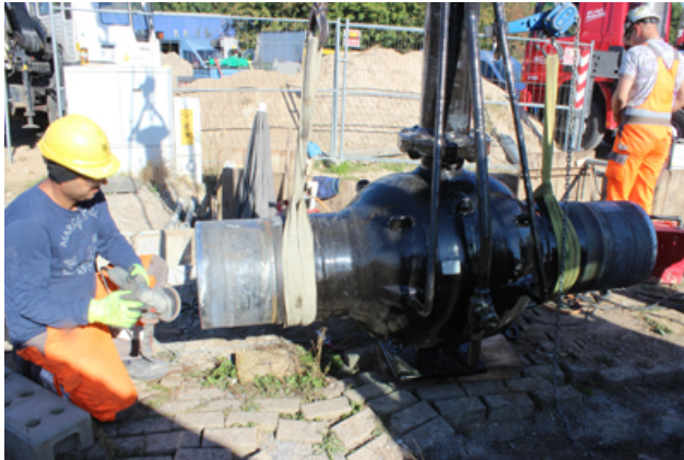
Neues Kugelventil vor dem Einbau.
