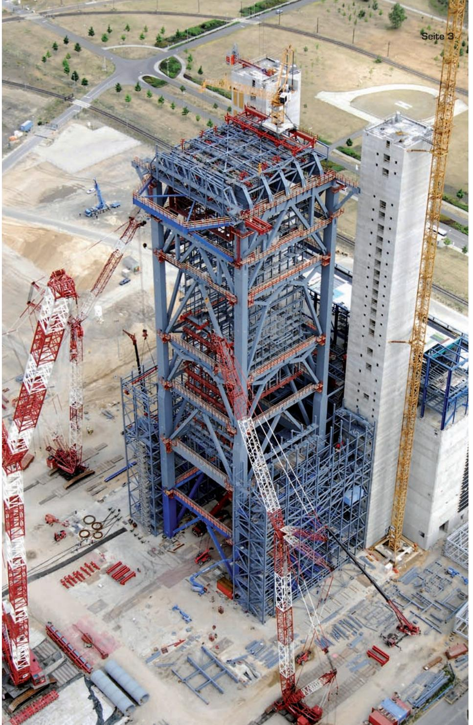
/ 30 Jahre Erfahrung im Stahlhochbau – ein Spezialgebiet von Plauen Stahl Technologie ist das Erstellen von Kessel-, Luvo- und Bunkergerüsten für Kohlekraftwerke
